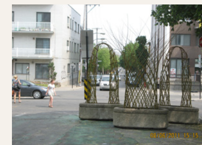
À CAUSE DES CONDITIONS CLIMATIQUES, LES MODALITÉS DE POSE DU FABRICANT N'ONT PAS PU ÊTRE RESPECTÉES DANS LA RUE SAINT-DOMINIQUE, CE QUI A EU UN IMPACT SUR LA DURABILITÉ DU PRODUIT.
